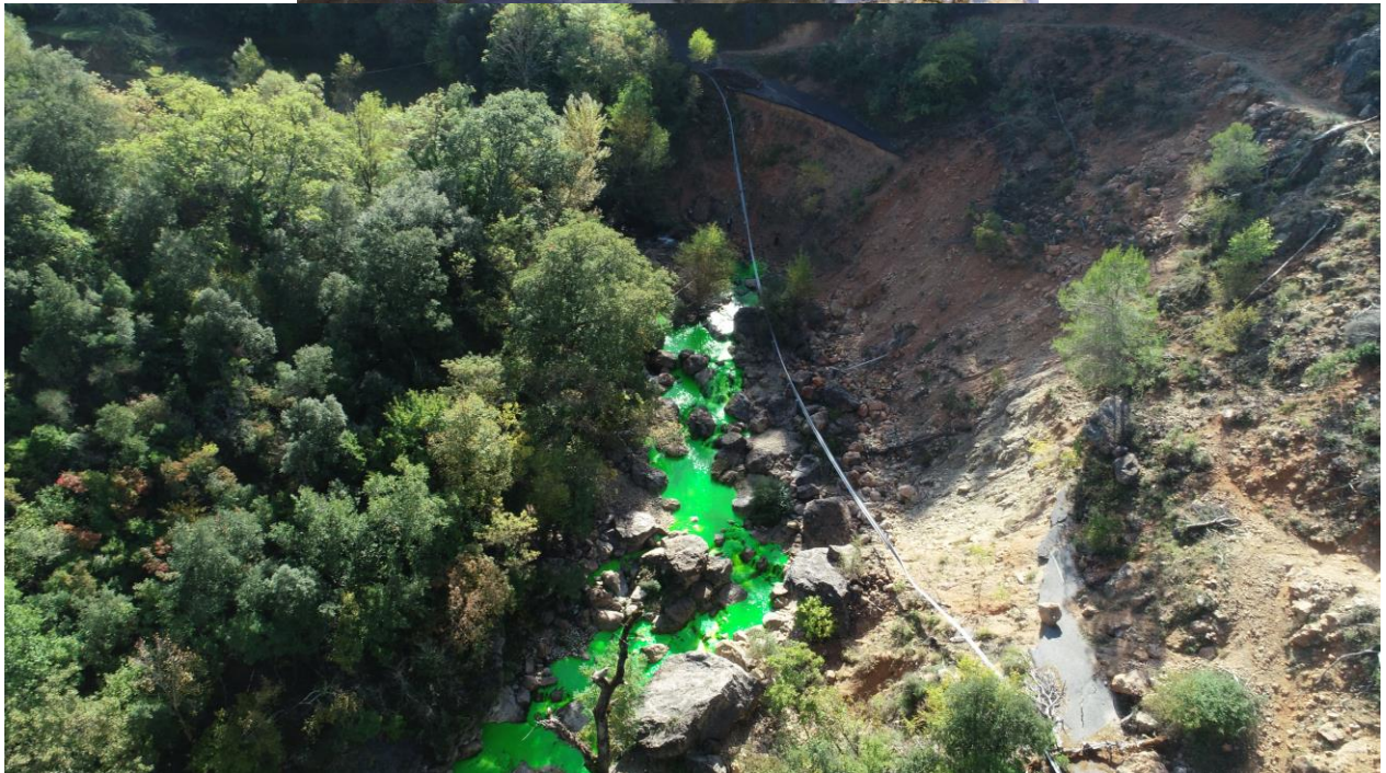
Figure 38 : Photographies prises lors de l'injection
